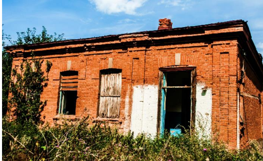
Рис. 2. Романовская школа – вид на второй этаж здания
