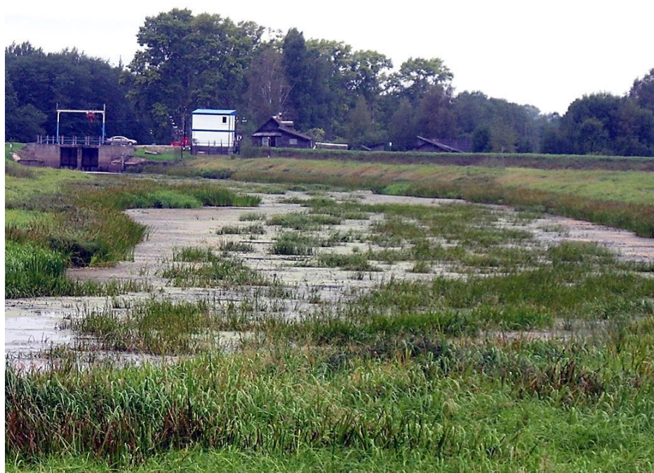
Рис. 4. Река Тверца ниже Старо-Тверецкой плотины, 2021 г. (фото В.И Николаев)
