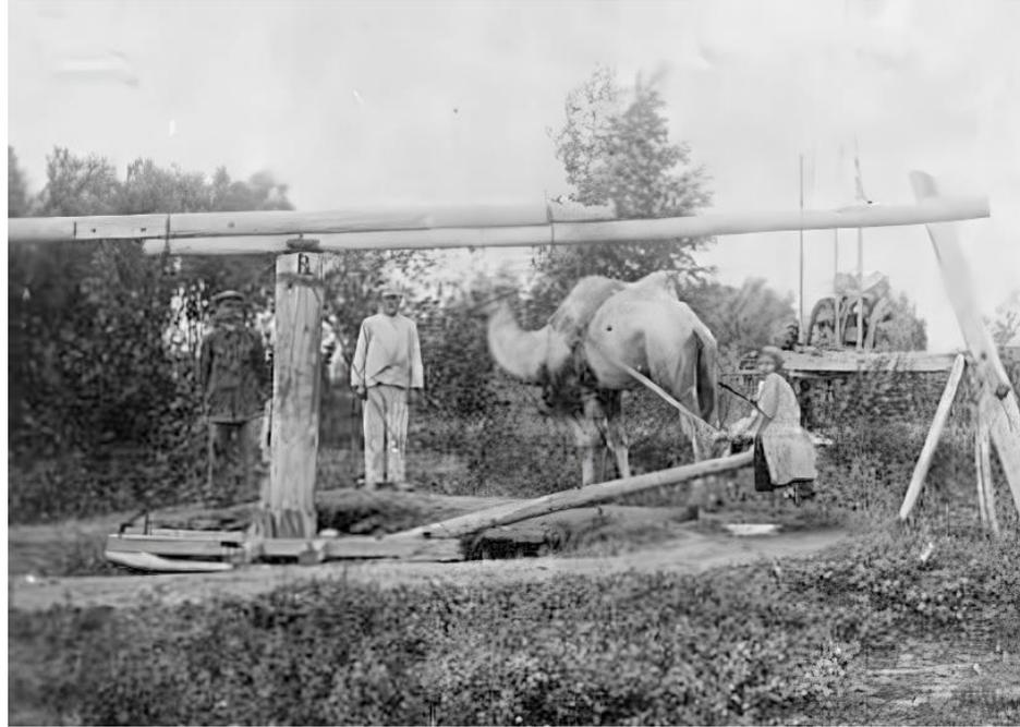
Рис. 1. Подъем воды для орошения полей с помощью примитивного подъемного сооружения (чигиря) в Новоузенском районе Саратовской области (фрагмент фото 1927 г.<sup>1</sup>)
